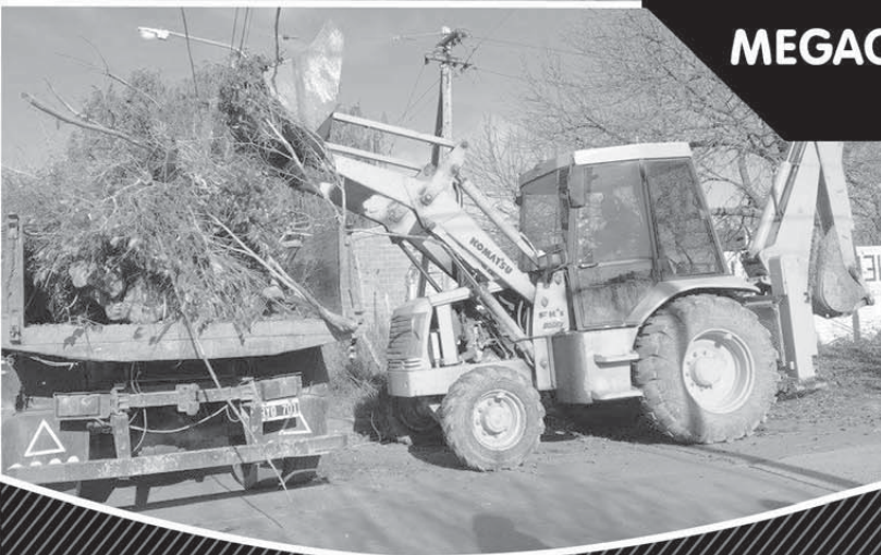
↙ MANTENIMIENTO DEL CANAL DE AVENIDA 66
