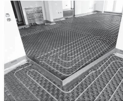
El sistema de tuberías de **REHAU** se caracteriza, ante todo por su fácil manipulación y su rápida técnica de unión sin calor.
