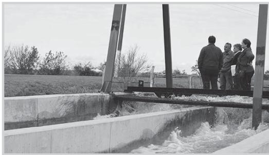
comienzan a funcionar en una primera etapa, sacando más de 400 litros de agua por segundo y luego se lleva a cabo la repotenciación del Watzenborn, donde se agregan las tres bombas más grandes, que expulsan 700 litros de agua por segundo cada una”, explicó el funcionario.
