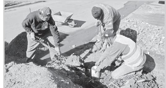
Comenzó la instalación del alumbrado público en calle 8, en el tramo que va de 124 a 143, cuyo pavimento se inaugurará a fines de 2017. Las primeras acciones abarcarán la realización de los pozos en los que se colocarán las respectivas columnas (cuatro por cuadra).
