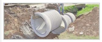
La Municipalidad efectuó en los últimos días trabajos relacionados con el entubamiento de zanjas en calle 30 entre 175 y 176. Las acciones abarcaron la extracción de antiguos caños de 300 mm. de diámetro y la colocación de una nueva cañería de 1.000 mm. con el objetivo de intentar dar solución a los reiterados anegamientos que experimentó la zona en días de tormentas intensas.
